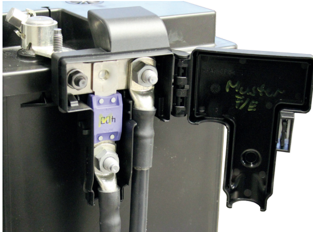
Bild 1. Vorsicherungsboxen schützen Komponenten des Bordnetzes und Leitungen vor einer Überlastung durch hohe Ströme © FEP
